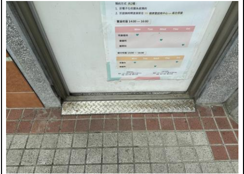
第六大樓行政單位入口 門檻改善設施
