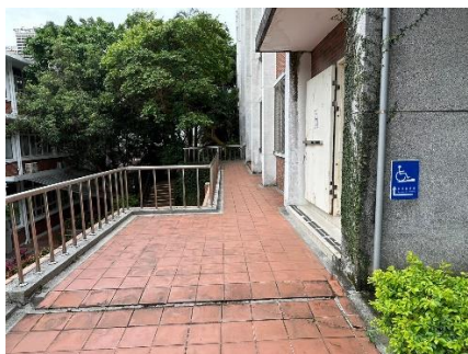
戴蓀堂右側入口無障礙斜坡道
