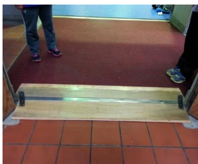
綜合大樓 3 樓體育館通道 木製緩坡斜板
