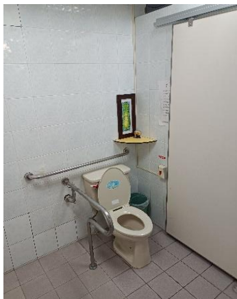
松勁樓無障礙廁所
