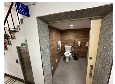
戴蓀堂 1 樓無障礙廁所
