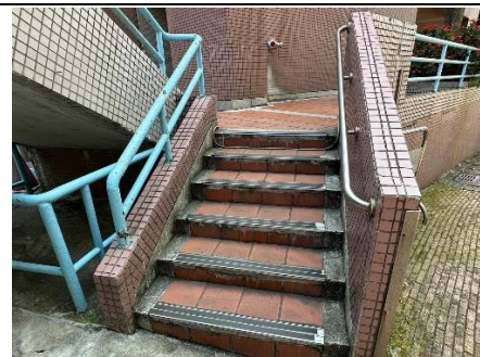
綜合大樓左側樓梯加設扶手
