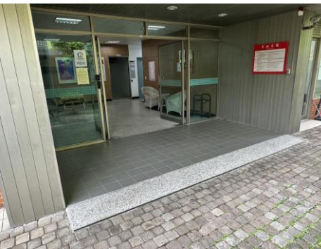
第四大樓正門入口無障礙斜坡
