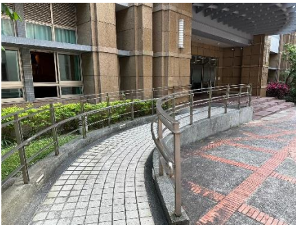
第一教研大樓正門無障礙斜坡道
