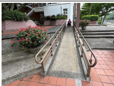
綜合大樓通往寵惠堂 無障礙斜坡道
