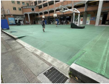
第六大樓前籃球場無障礙斜坡
