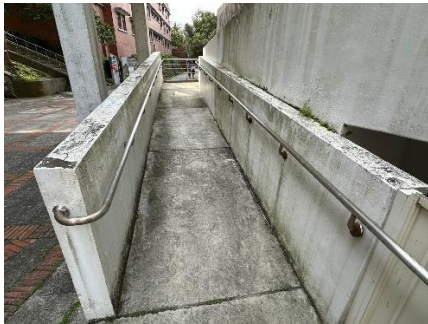
中正圖書館正門無障礙斜坡道
