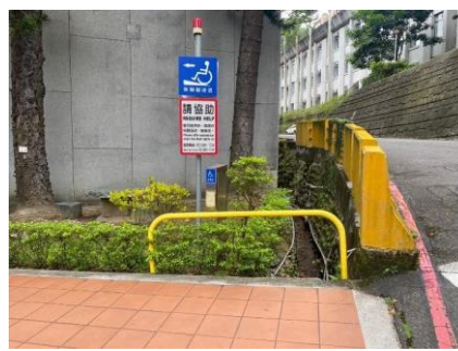
戴蓀堂右側無障礙斜坡道 設置無障礙求助鈴
