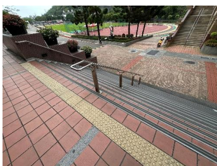
綜合大樓第通往二教研大樓 樓梯扶手、導盲磚及防滑設施
