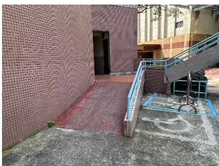
綜合大樓 1 樓左側無障礙斜坡道
