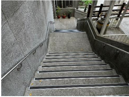
超庸館側邊樓梯扶手及防滑條
