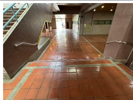
綜合大樓 B1 階梯旁加設扶手
