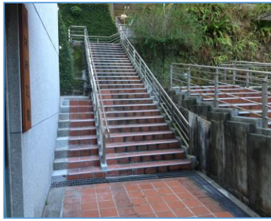
雷德樓西側樓梯扶手
