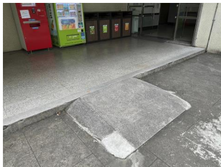
第一大樓後門無障礙斜坡
