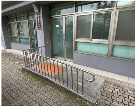
第三大樓一樓註冊課務組入口 無障礙斜坡道
