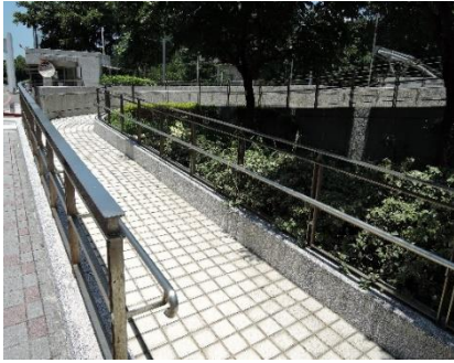
室外籃球場無障礙斜坡
