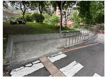
教師研究二樓外側通往松勁樓 無障礙通道
