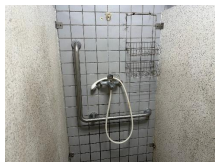
綜合大樓 3 樓體育館 盥洗室 L 型扶手
