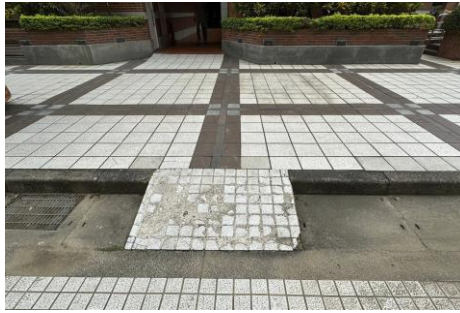
第五大樓往第二大樓側邊入口 人行道無障礙斜坡
