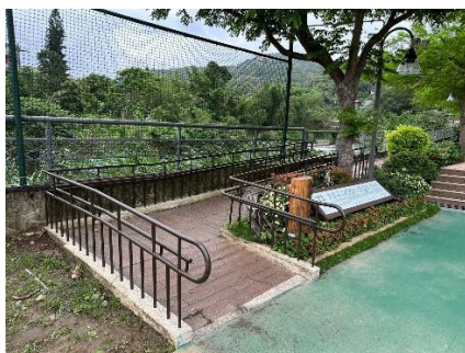
第二教研大樓後方友朋步道 無障礙斜坡道
