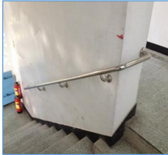
教師研究二樓內部樓梯扶手
