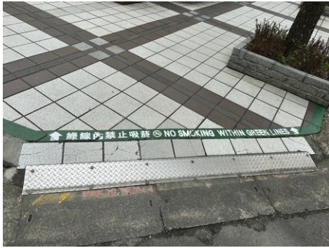
第五大樓至第二大樓外部人行道 無障礙斜坡
