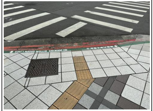
第五大樓外部人行道無障礙斜坡
