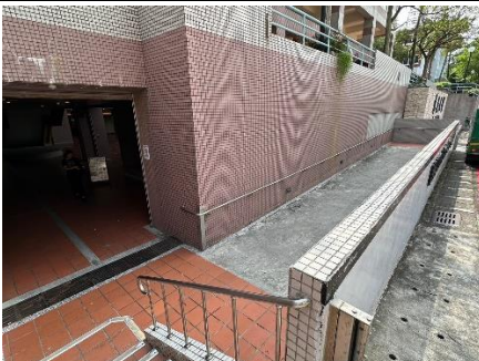
綜合大樓通往 B1 無障礙斜坡道
