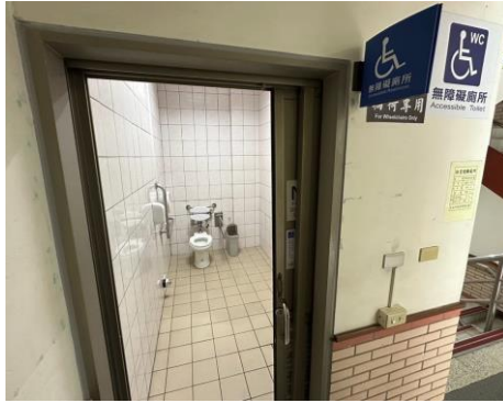
第六大樓1樓無障礙廁所
