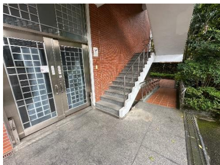
寵惠堂右側入口無障礙斜坡道
