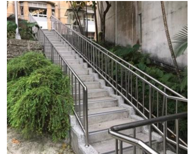
教師研究二樓左側後方樓梯 扶手及防滑設施
