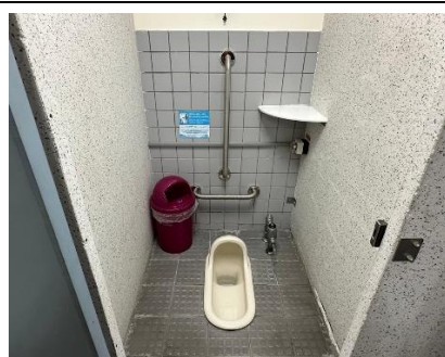
綜合大樓蹲式廁所加設 T 型扶手
