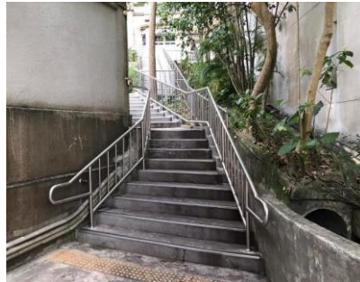
教師研究二樓左側樓梯 扶手及防滑設施
