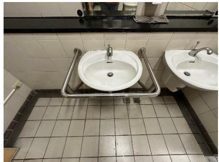
第一教研大樓廁所洗手台扶手
