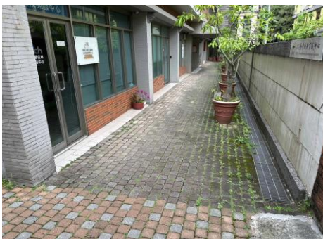
第四大樓無障礙通道
