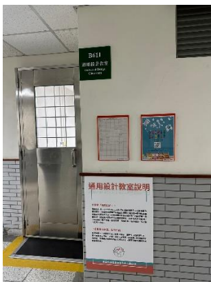
綜合大樓 B611 語言教室 (通用設計教室) 設置無障礙斜坡入口及友善專區
