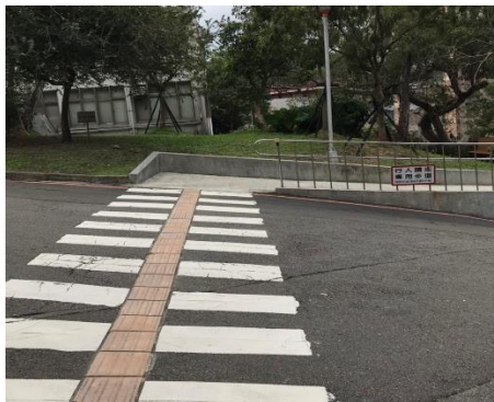
松勁樓入口處馬路導盲磚
